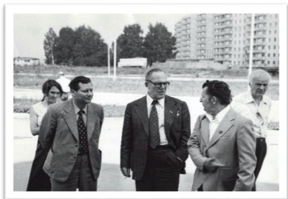
Строительство городка, поселок Краснообск Новосибирский район, НСО
